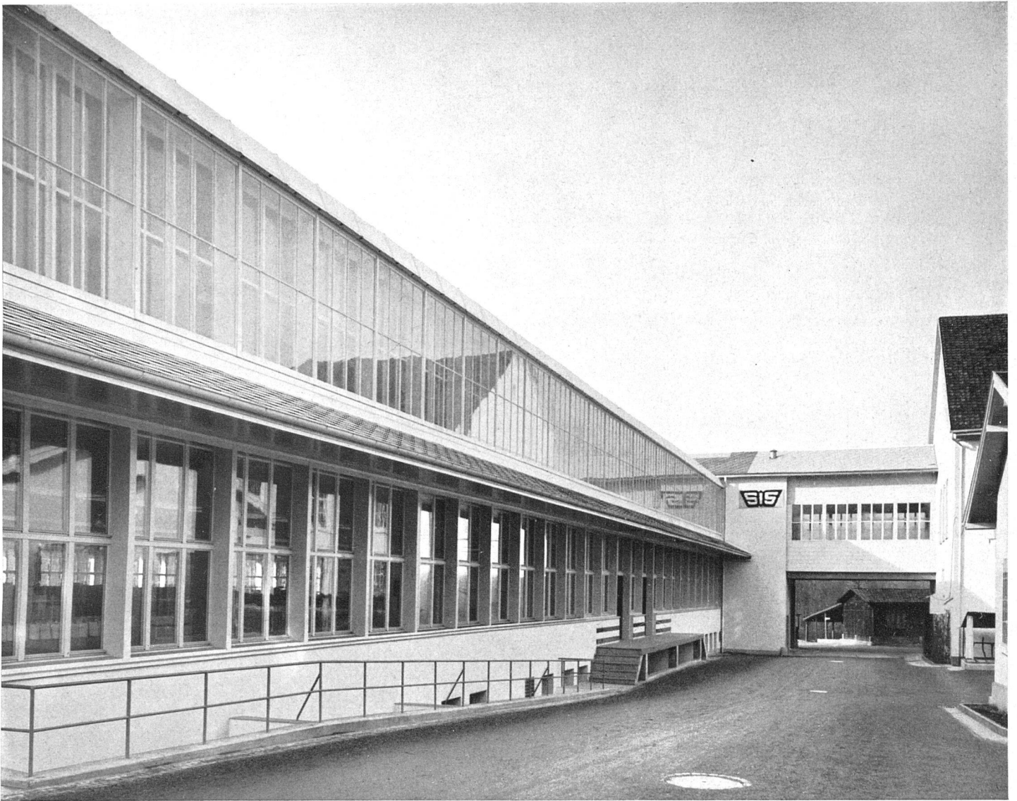
Ansicht des Neubaus von der Fabrikstraße. Das Vordach schützt Laderampe und Lichtschächte. Shedfirst mit Spezialstücken aus weißem Eternit eingedeckt
