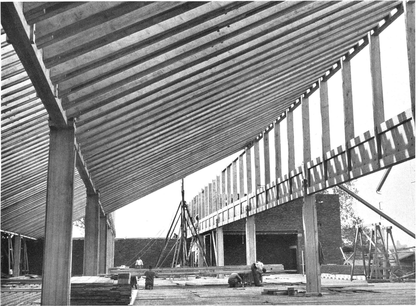
Spinnereigebäude SIS in Arlesheim. Rohbauansicht: Verleimte Stützen, durchgehender Nagelträger mit aufgesetzten Sheds
