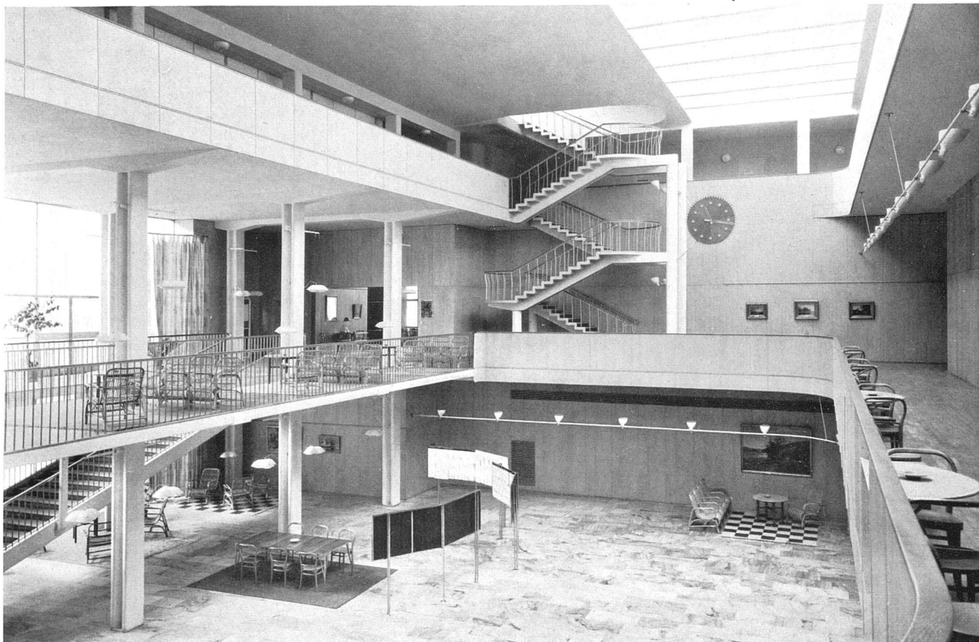
Gunnar Asplund 1885–1940 Eingangshalle des erweiterten Rathauses von Göteborg 1934–37
