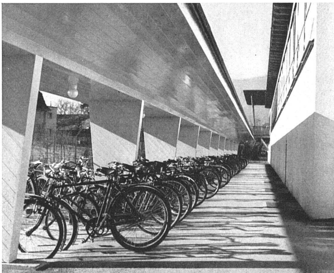
Fahrradständer in Nagelkonstruktion
