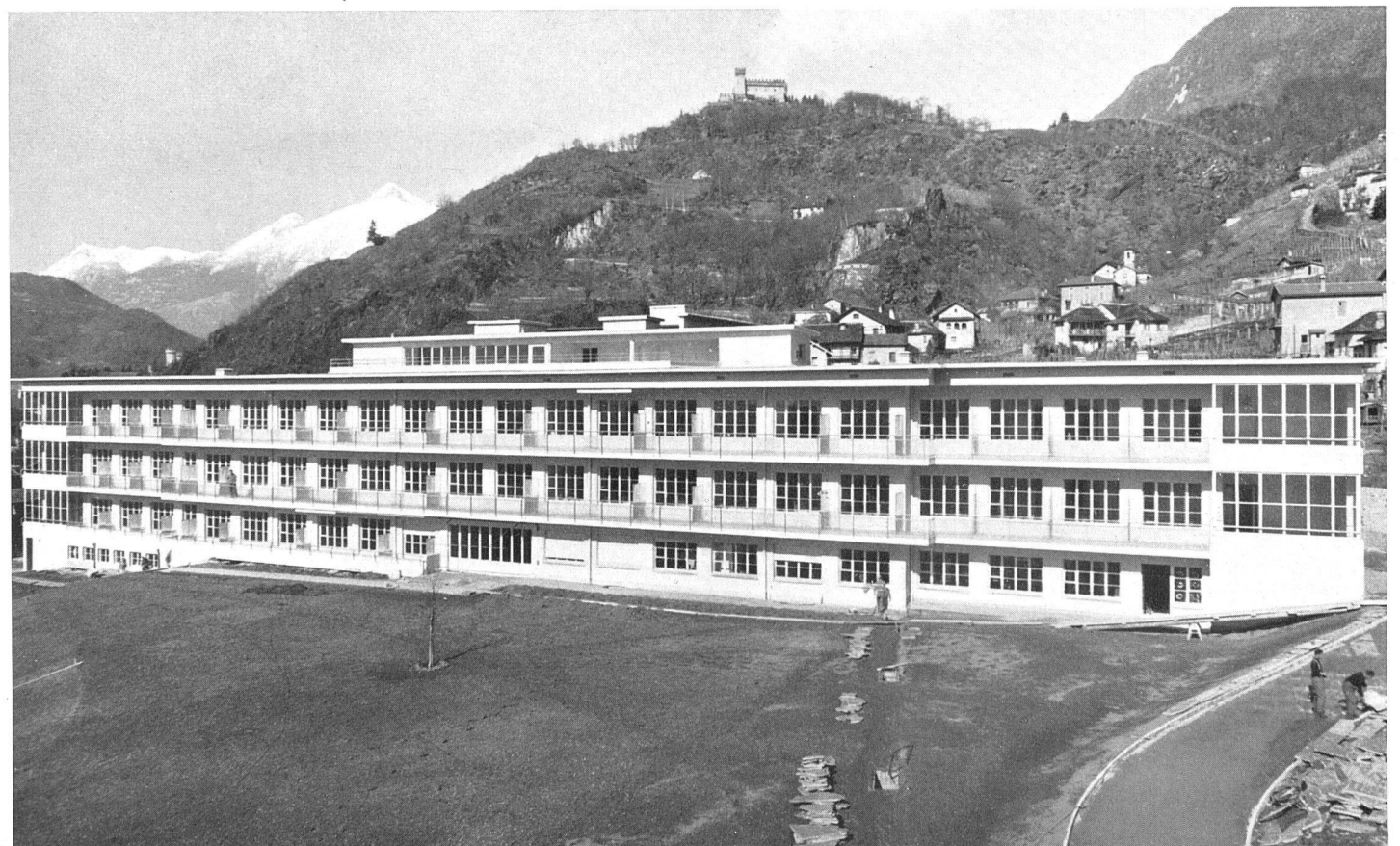
Gesamtansicht von Süden
