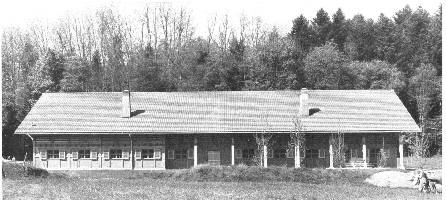
Gesamtansicht von Süden
