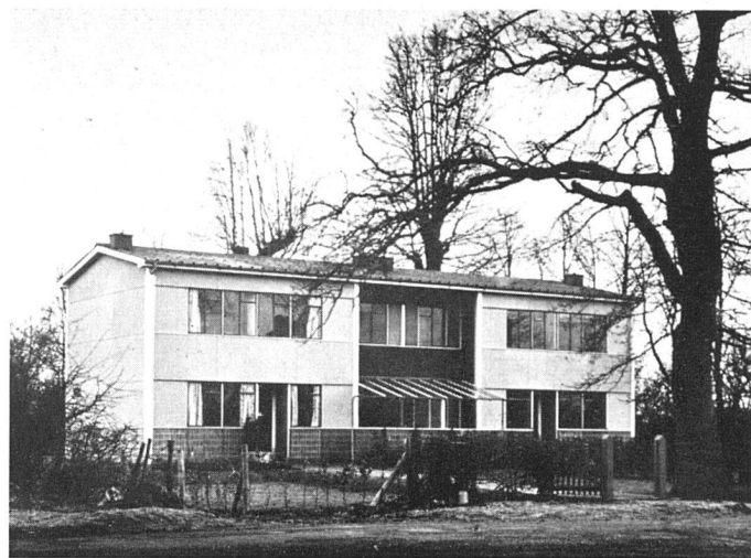
et panneaux de béton armé léger
