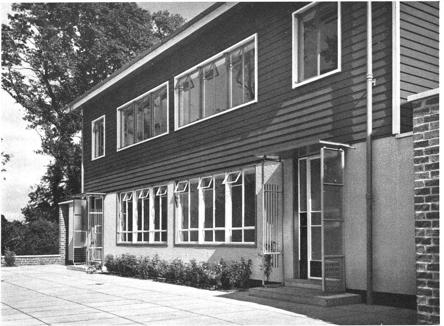
Maison d'après-guerre exposée à Northolt dessinées par F. Gibbert, arch. F.R.I.B.A., avec galendage horizontal en tôle d'acier galvanisée et peinte
