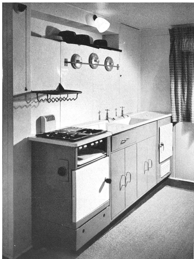
Batterie de fourneau, évier et frigidaire
