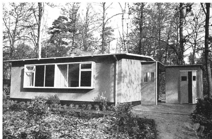
Bungalow terminé à destinée provisoire
