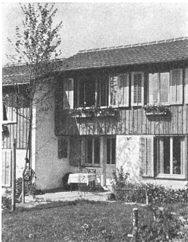
Siedlung auf dem Zollikerberg. Architekten: M. Aeschlimann und A. Baumgartner BSA, Zürich
