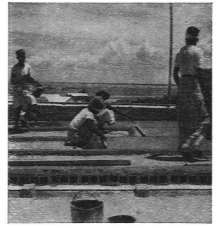
Dachterrasse, Verlegen der Tonplatten
