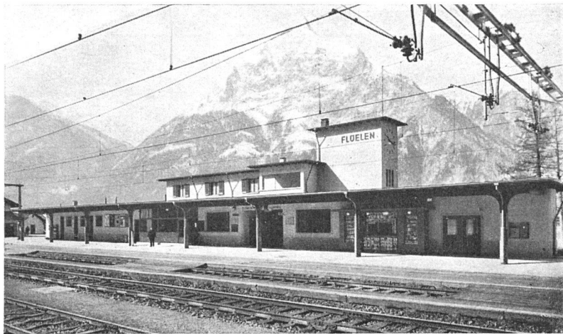
Neues Stationsgebäude in Flüelen. Entwurf und Bauleitung: Hochbaubüro der Bauabteilung SBB Luzern, Sektionschef: Alfred Ramseyer, Arch. BSA. Photo: R. Aschwanden, Altdorf. Nr. 10332 BRB 3. 10. 1939
