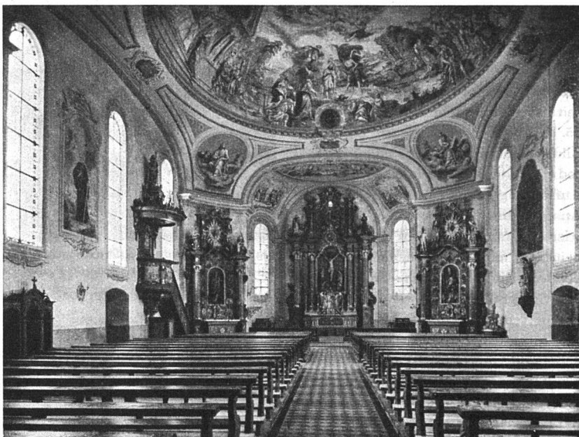
Die katholische Pfarrkirche in Niederhelfenschwil vor der Renovation
