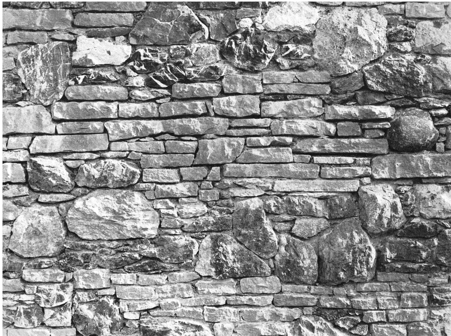
Querschnitt aus einer Gartenmauer, grau-grüne Sandsteine, durchsetzt von roten und grauen Ackersteinen, aus nahem Moränenhügel stammend Baumann, Gartenarchitekt BSG, Thalwil
