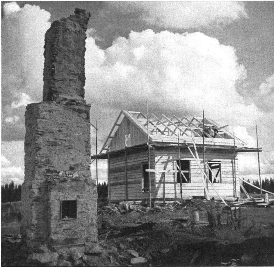
Der Wiederaufbau beginnt
