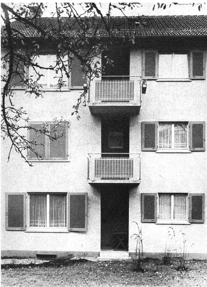
Fassadenausschnitt Balkon mit wegnehmbaren Schutzschirmen aus Rolladenpanzern
