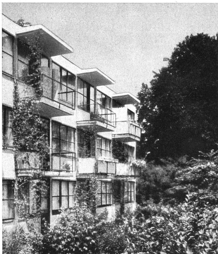
Heim für alleinstehende Frauen in Basel, 1929 Architekten BSA Artaria & Schmidt
