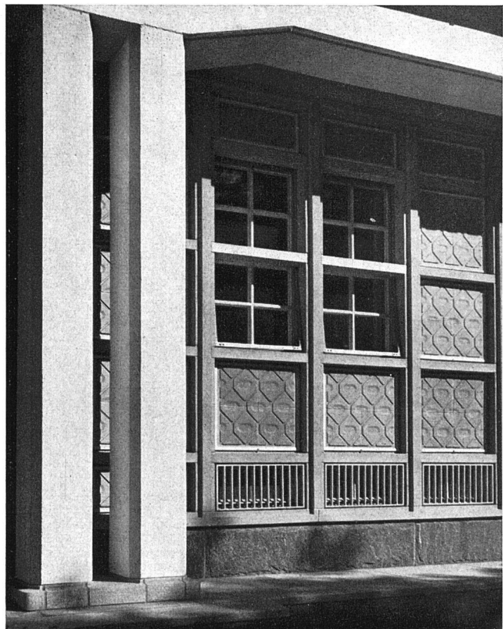
Abb. 38 Teilansicht der nichttragenden Außenwand des Geschosses A mit Betonraster. Füllungen mit Klinkerplatten verblendet
