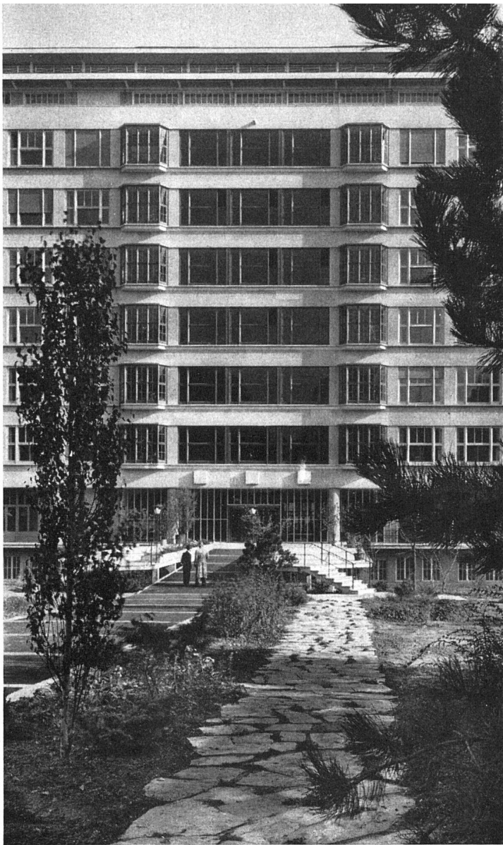
Mittelpartie der Gartenfront mit Austritt aus der Eingangshalle
