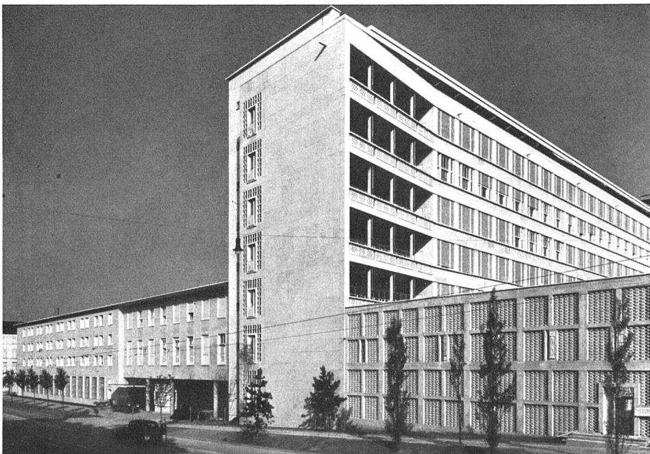
Ansicht von der Schanzenstraße
