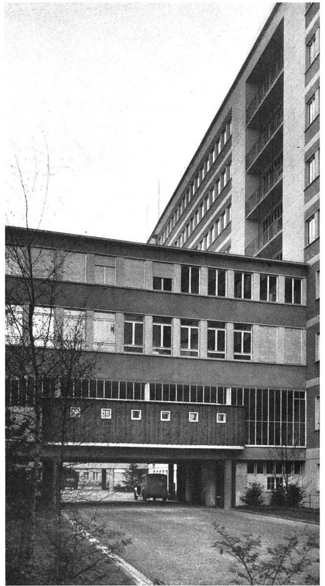
Mittlerer Verbindungsbau mit interner Spitalstraße und Patientene
