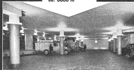
Isolation der Kellerräume gegen Grundwasser System „Mammut“ ca. 5800 m 2
