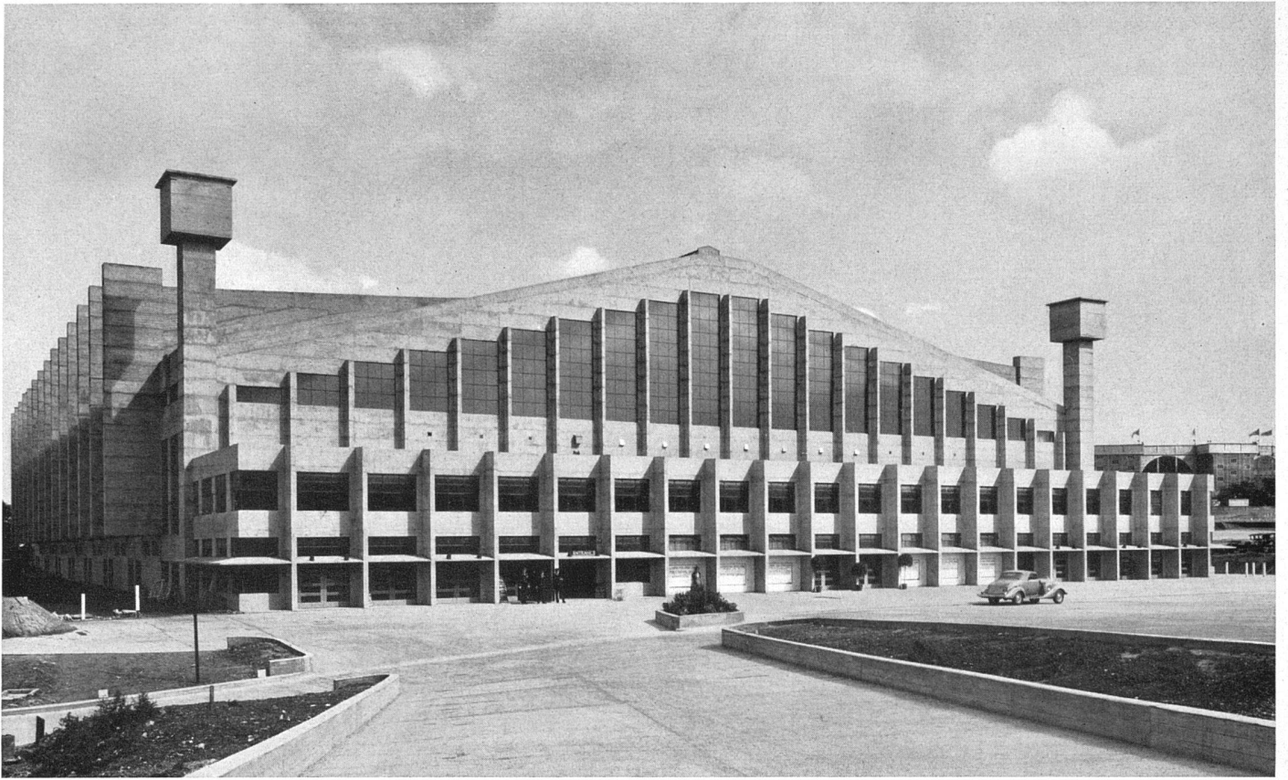
Eingangfront, links und rechts Wasserreservoirs / Façade; à droite et à gauche, des réservoirs / Entrance elevation, right and left water tanks
