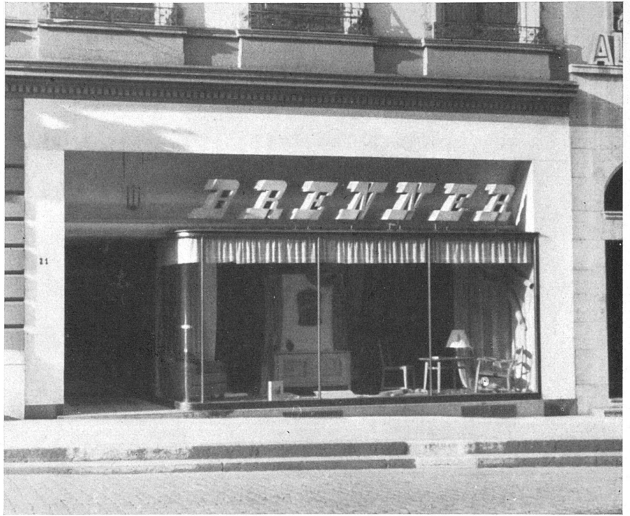
Ansicht von der Straße / La nouvelle façade / The new street front
