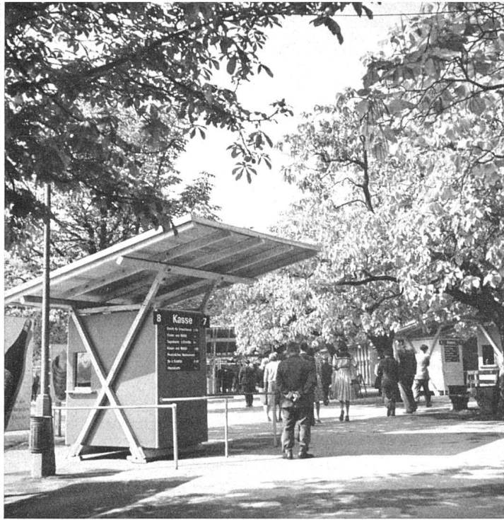
Haupteingang: Einzelkassen, locker in den Besucherstrom gestellt | Entrée principale avec caisses librement disposées | Main entrance with single cash-boxes
