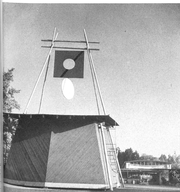
Kino. Vier Rundholzstangen bilden die Träger des Daches und des Signetes | Cinéma; 4 poteaux supportent le toit et les insignes | Cinema; 4 poles support the roof and the emblem
