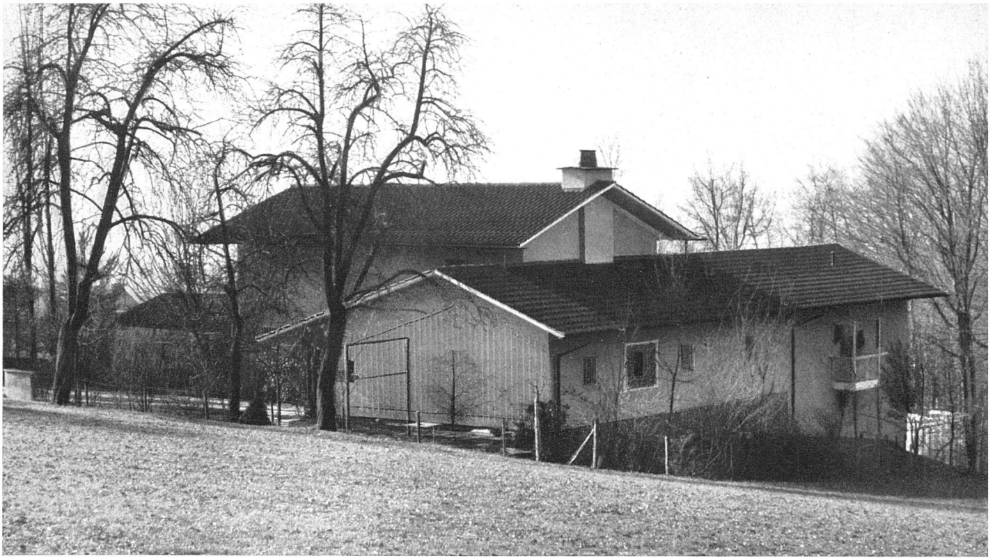
Gesamtansicht von Norden / Vue d'ensemble (nord) / General view from the north
