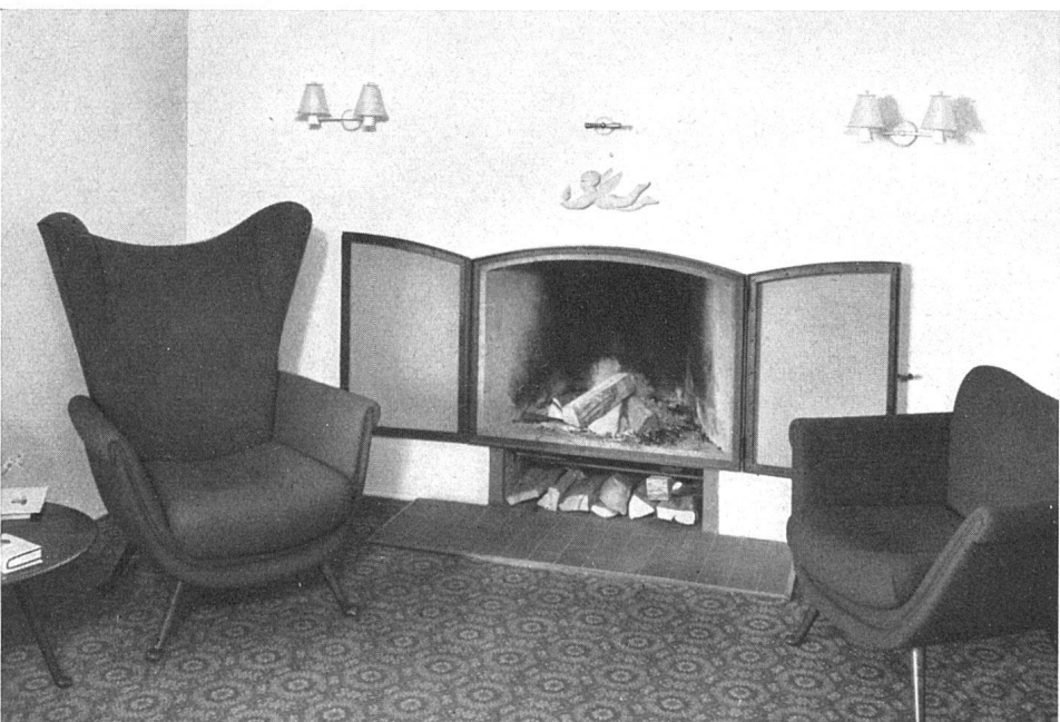
Cheminée im Wohnraum, Funkenfang als Türen ausgebildet, Möbel nach Entwurf des Architekten | Cheminée dans la grande salle | Fire-place in the living-room
