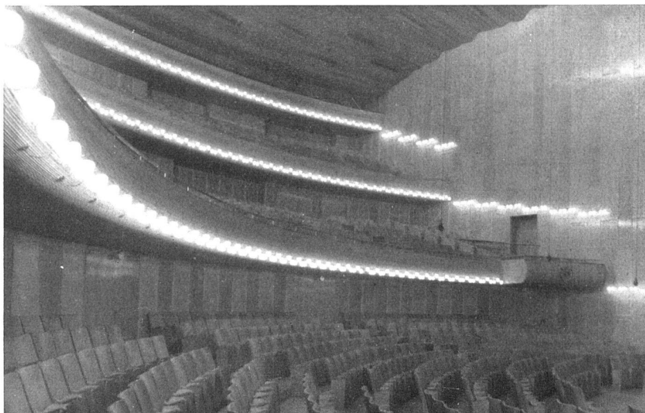
Konzertsaal, rechts Königsloge. Wände und Decke mit Ahornplatten verkleidet. 1200 Sitzplätze / Salle de concerts, à droite la loge royale; 1200 places; parois et plafond revêtus de contre-plaqué d'érable / Concert hall seating 1200; at right the royal box; maple panelling on walls and ceiling
