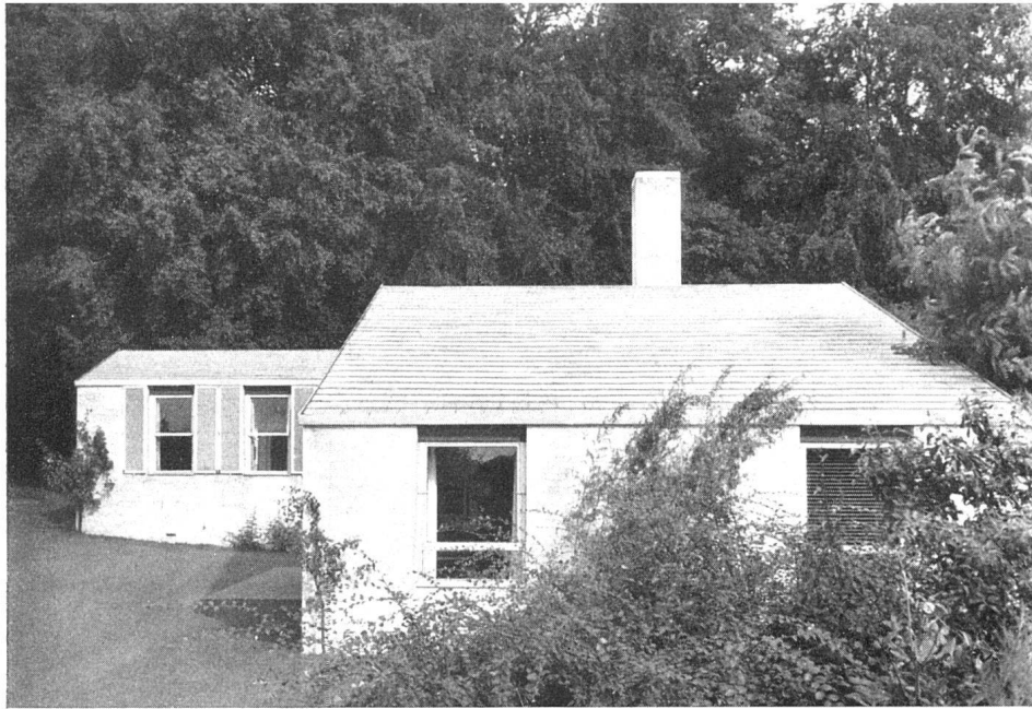
Ostansicht / Vue prise de l'est / View from the east
