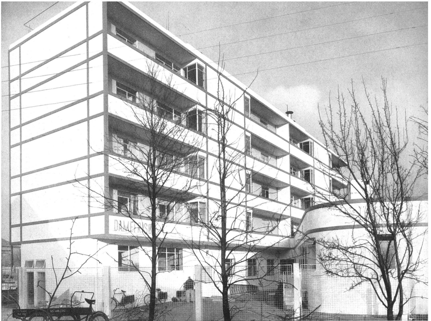
Südfront mit Hofeingang. Eisenbeton-Skelettbau | Façade sud et entrée de la cour; gros-œuvre en béton armé | South elevation and access to the reinforced concrete construction
