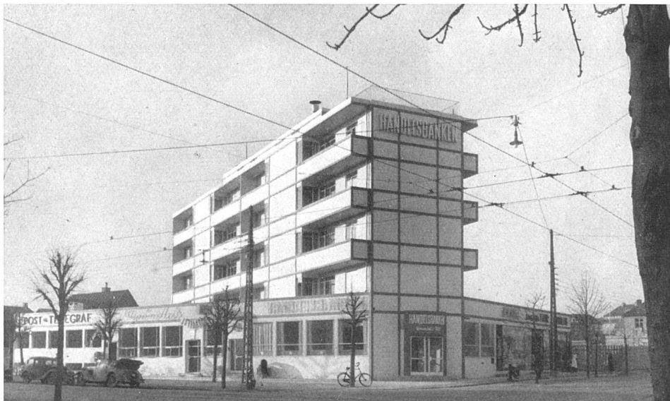
Straßenansicht von Osten | Vue prise de la rue (est) | View from the road (east)
