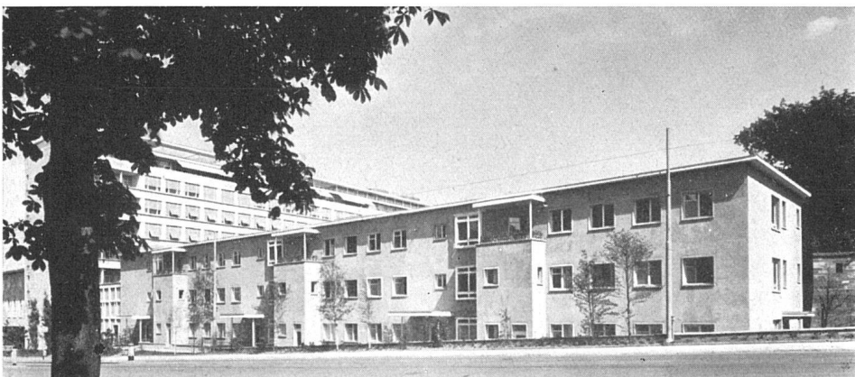
Gesamtansicht von Westen, im Hintergrund Bettenhaus des Bürgerspitals | Façade nord-ouest, à l'arrière-plan le bâtiment principal de l'hôpital | North-west elevation, in the background the main building of the hospital
