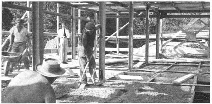
Stahlskelette für Montagebau bestens geeignet / Ossature métallique pour constructions rapides / Steel-frame for quick assembly
