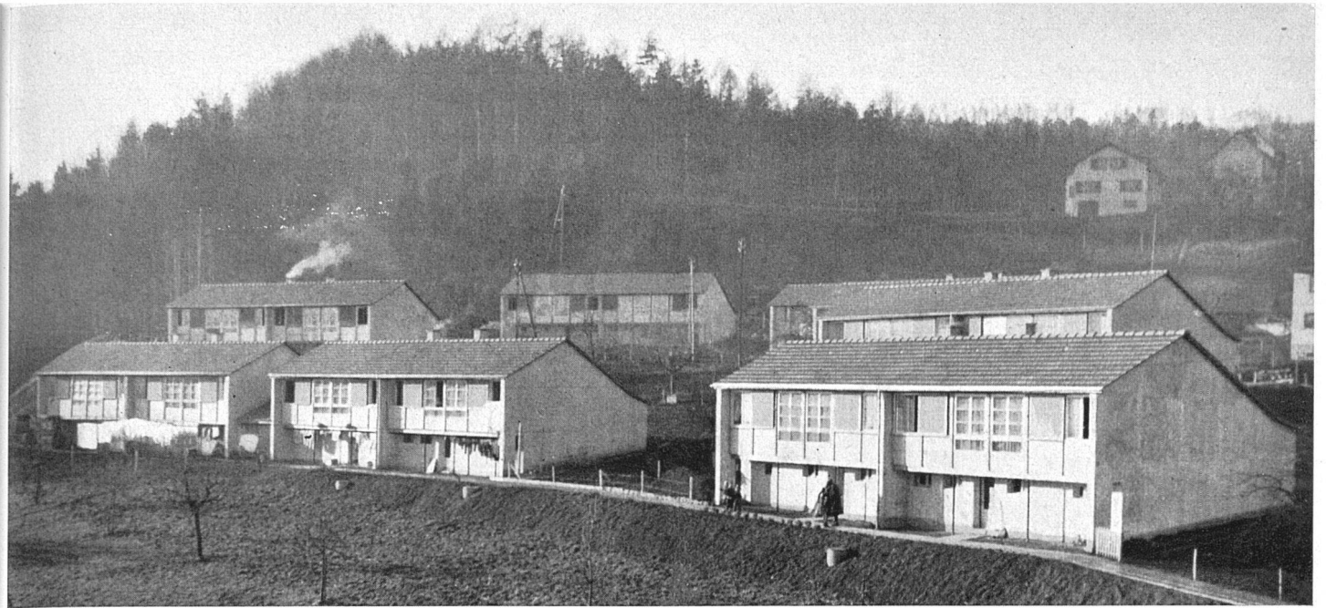
Gesamtansicht der Siedlung von Nordosten / L'ensemble de la cité vue du nord-est / General view of the scheme (north-east)
