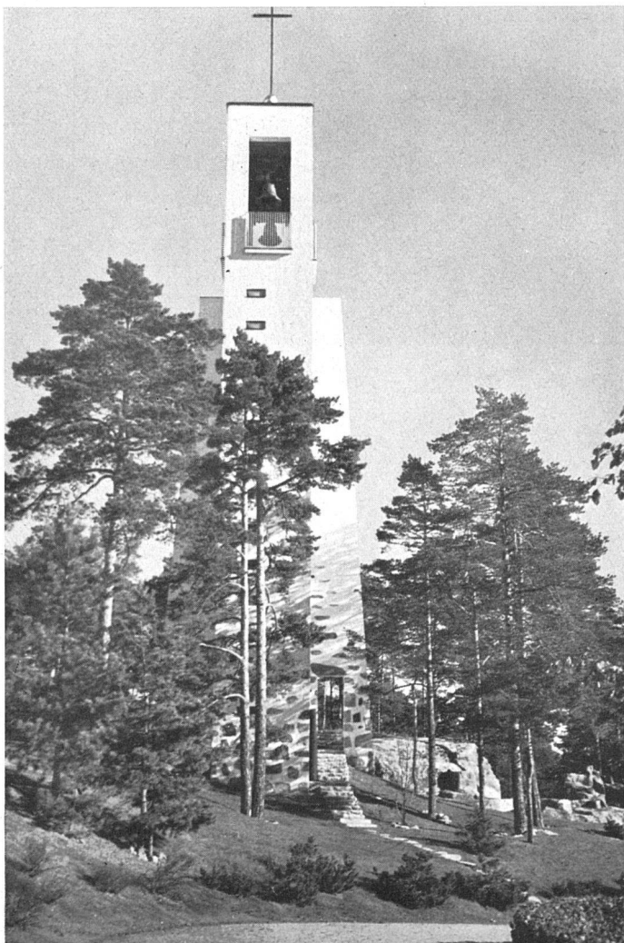
Der freistehende Glockenturm / Le clocher / The belfry
