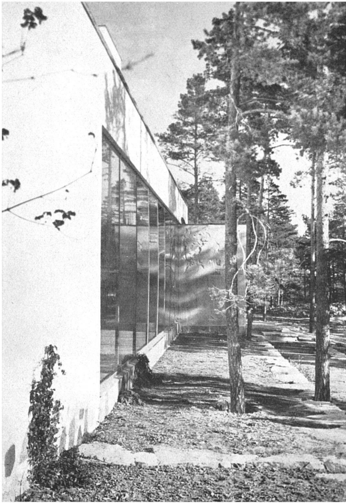
Glasfront des Seitenschiffs / Paroi de verre du bas-côté / Glass wall of the side nave
