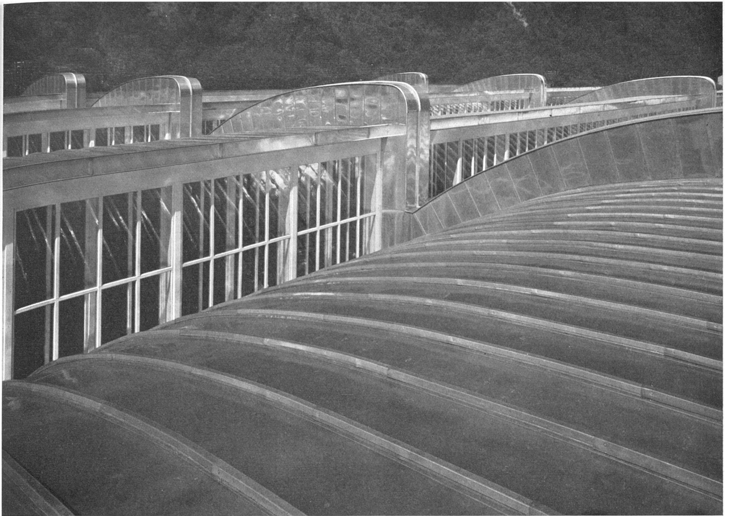
Blick über die mit Aluminiumblech eingedeckten Sheds / Les «sheds» couverts d'aluminium / Aluminium-covered saw-tooth roof
