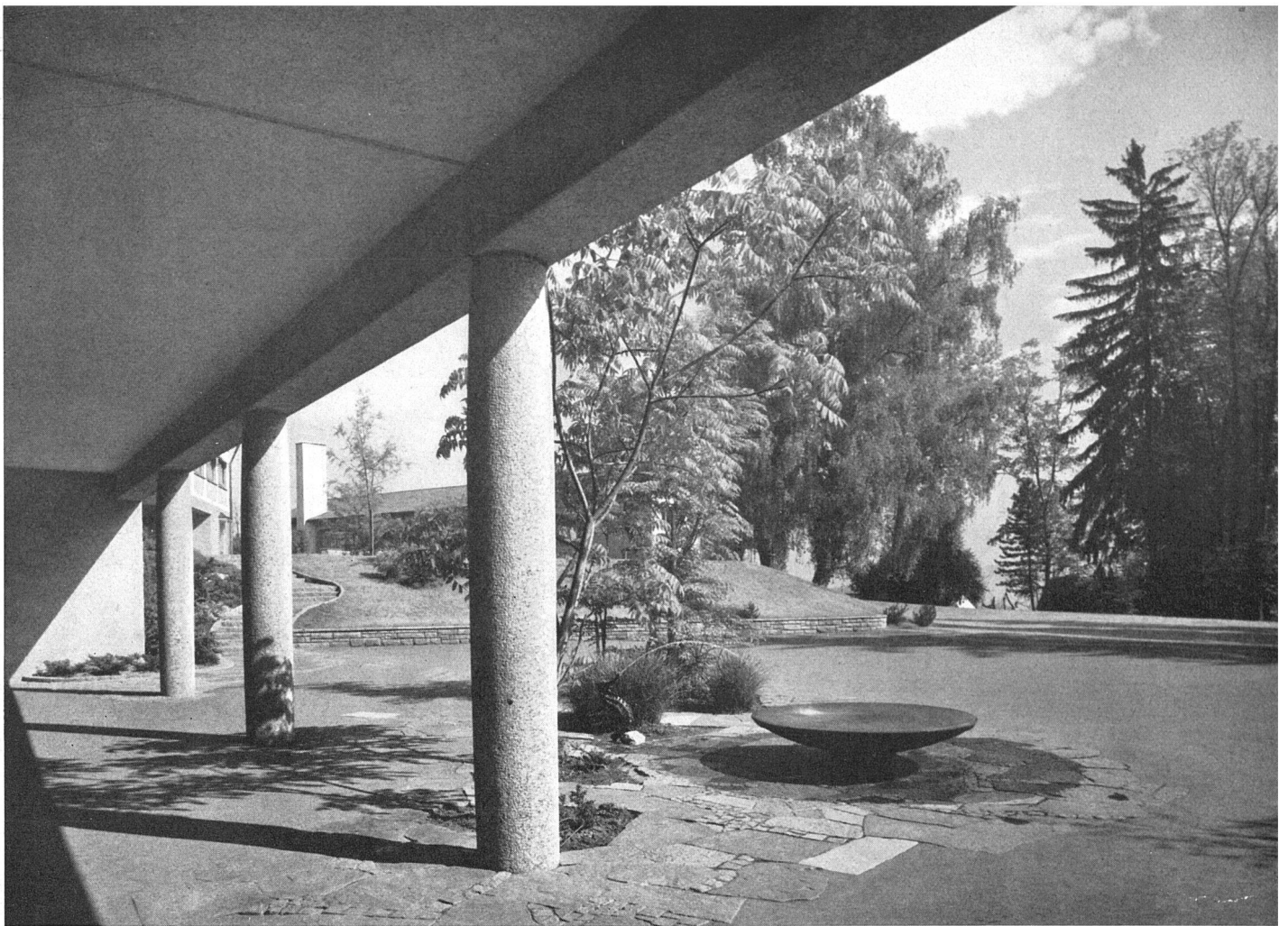
Spielhalle und Pausenplatz mit Brunnenschale und Wasserspeier (Seepferdchen von Paul Kyburz, Luzern). Säulen aus Osogna-Granit, Bodenbelag c Quarzitplatten, bunter Kleinpflasterung und hellbraunem Asphalt | Præau ouvert et terrain de récréation avec vasque alimentée par un hippocam Colonne de granit, sol en dalles de quartzite, mosaïque polychrome et asphalte | Covered play-hall and recreation ground with fountain and jet in form of a sea-horse. Columns of granite, flooring of quartzite slabs, coloured mosaic and asphalt
