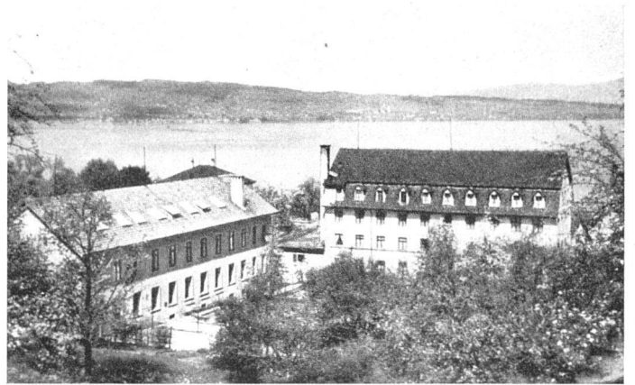
Diese ehemalige Fabrik wird heute, obwohl völlig ungeeignet, als Heim für schwererziehbare Mädchen benützt (Schweiz. Erziehungsheim in Richterswil) | Une usine d'autrefois – bien qu'absolument improposable aujourd'hui d'institut de rééducation pour jeunes filles | A former factory serves – inappropriately – as a girl's reformatory
