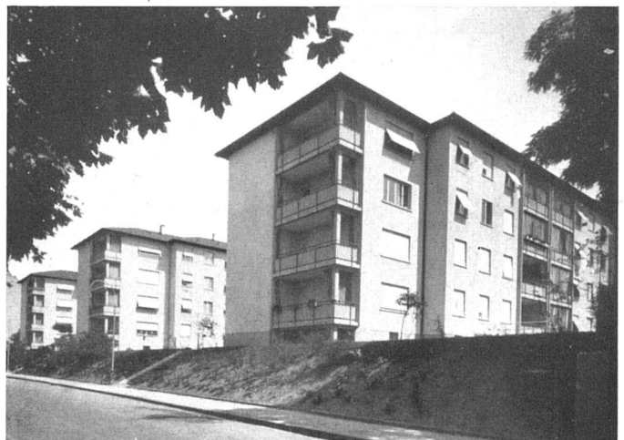
Nordwestansicht / Vue du nord-ouest / View to north-west
