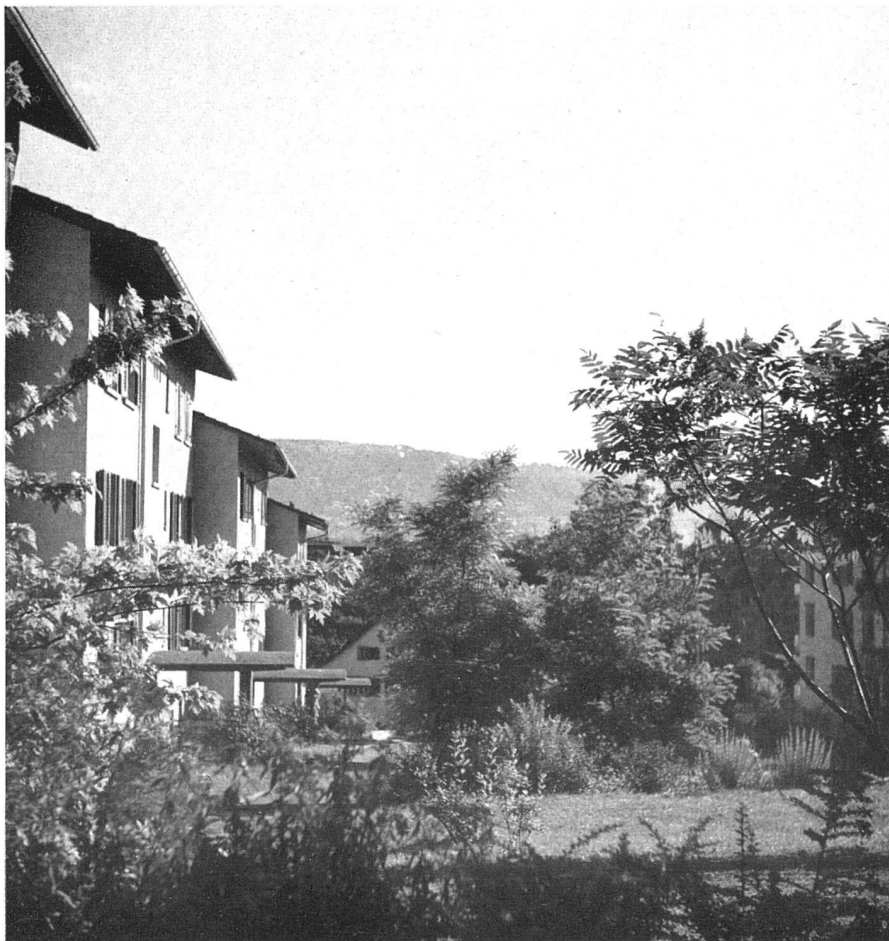
Eingangsseite mit Ziersträuchern | Entrée avec plantes d'agrément | Entrance with ornamental shrubs
