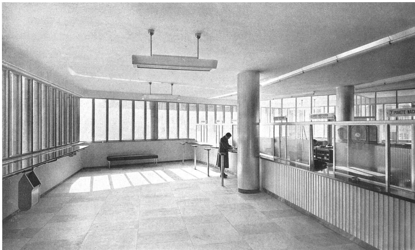
Post-Schalterhalle. Fenster in Beton mit Lamellenstoren innen. Säule mit Anticorodal verkleidet | Halle des guichets. Fenêtres en béton avec stores intérieures à lamelles. Colonnes recouvertes d'anticorodal | Interior of post-office. Windows in concrete with interior lamel blinds. Pillars faced with anticorodal
