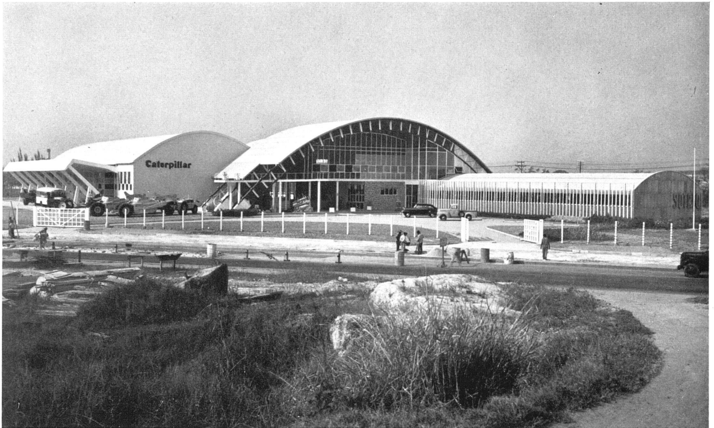
Hauptansicht | Vue générale | Front elevation
