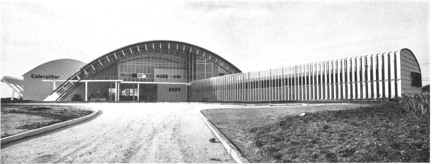
Gesamtansicht. Rechts Bürogebäude, Mitte Besucherteil und Ausstellung, links Werkhalle. Bogen, 45 m Spannweite, in Holz mit Eternitabdeckung, vor den Büros Welleternit-Sonnenschutz | Vue générale. A droite les bureaux, au centre la salle d'exposition et la partie réservée aux visiteurs, à gauche la salle des machines. Arc en bois de 45 m de portée avec recouvrement en éternit. Devant les bureaux brise-soleil en éternit | General view, right offices, middle visitors' section and exhibitions, left workroom. Arch in wood, 45 m span, covered with eternit, facing offices wave-eternit sun breaker Interphoto News Pictures, Overseas-Press
