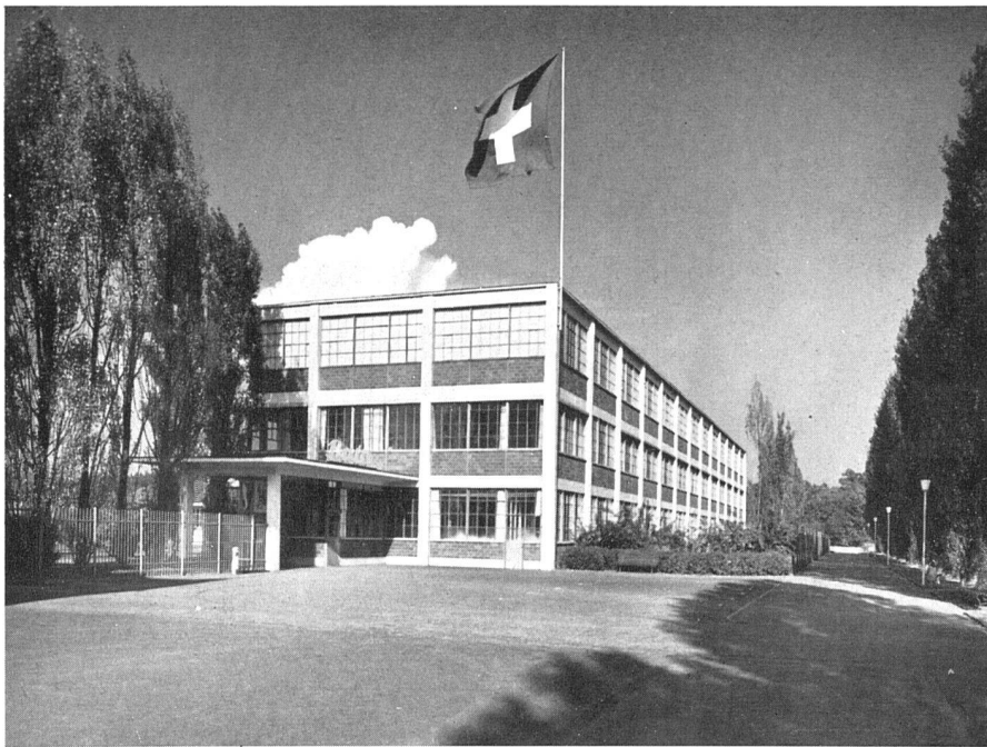
Fabrikgebäude mit Portierloge. Eisenbetonskelett mit roten Backsteinbrüstungen | Le bâtiment de l'usine et la loge du portier. Ossature en béton avec contre-cœurs en brique rouge | Factory building with doorkeeper's lodge. Reinforced concrete girders with red brick facing
