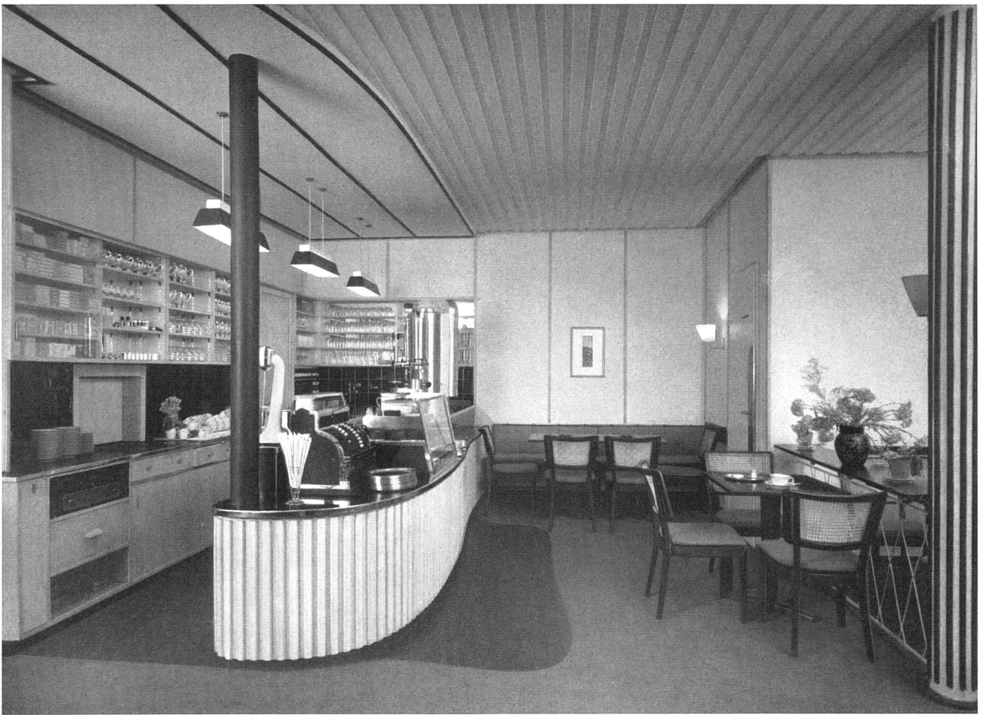
Buffetanlage. Wände Pavatex hell, Boden roter Spannteppich. Schreinerarbeiten in Esche natur | Le buffet. Parois claires en pavatex. Sur le sol, moquette rouge. Boiseries en frêne naturel | Bar. Walls light Pavatex, floor red all-over carpet. Woodwork in natural ash
