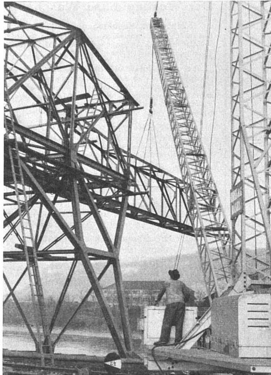
Montage der Stahlkonstruktion einer Entladeanlage für Brikettbündel im Auhafen Basel. Mühe-los hebt der Derrick Lasten bis zu 15t und bringt wie hier ganze Brückenteile an Ort und Stelle.
