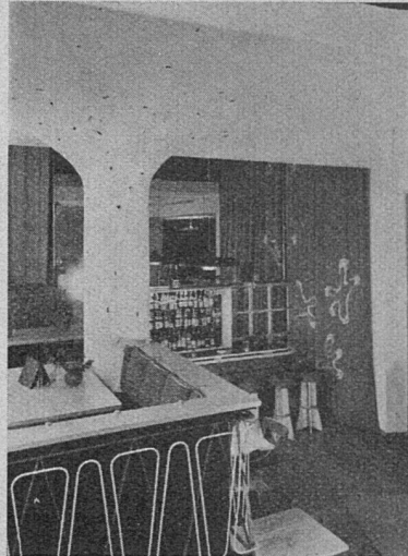
Umbau Roxy-Bar, Zürich Architekt: Bruno Giacometti SIA/SWB, Zürich
