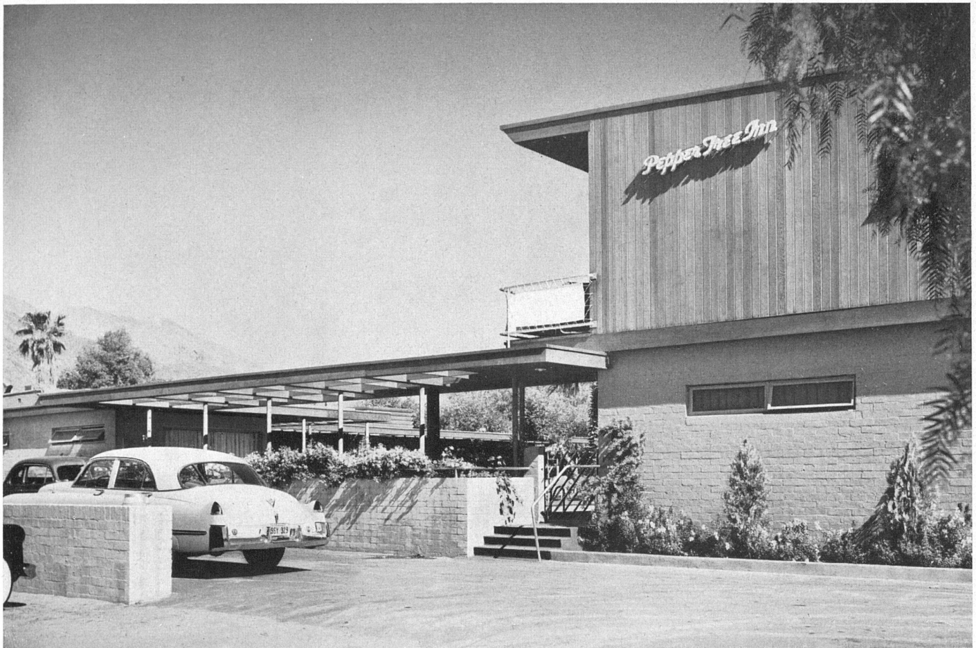
Gesamtansicht von Süden mit Parkplatz | Vue générale prise du sud, place de stationnement | General view from south with parking area
