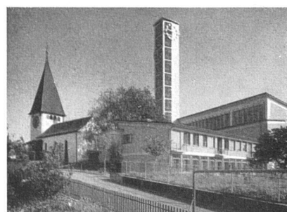
Reformierte Kirche in Altstetten-Zürich, 1942. W. M. Moser, Arch. BSA
