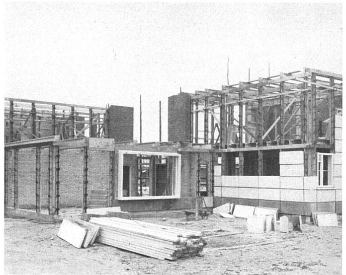
Das Bausystem besteht aus vorfabrizierten Betonelementen, Stahl und Backstein | Le système de préfabrication | The system of prefabrication (pre-cast concrete elements, steel, bricks)
