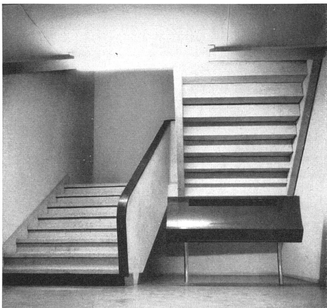
Escalier monté d'éléments préfabriqués | Treppe aus vorfabrizierten Betonelementen | Staircase made of prefabricated concrete elements
