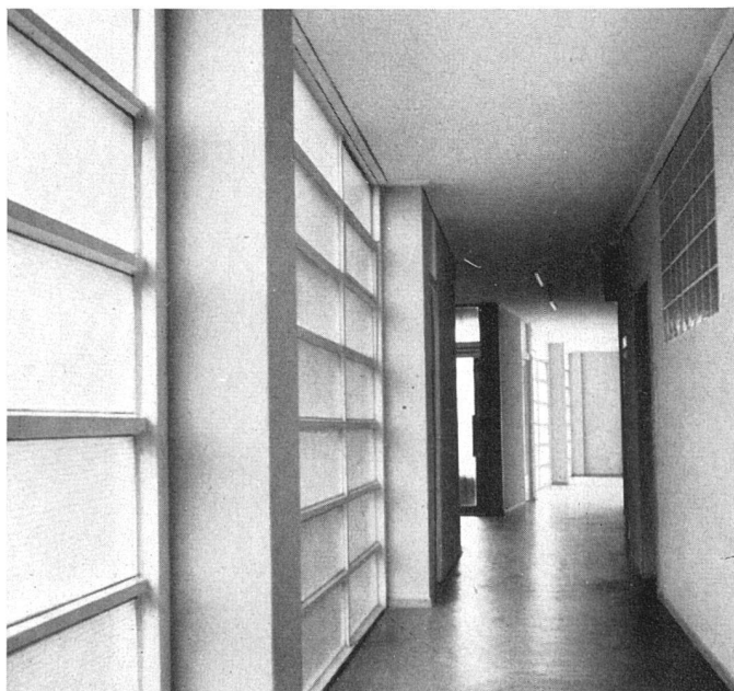
Corridor vitré; éléments de béton préfabriqués | Verglaster Gang; vorfabrizierte Betonrahmen | Glazed corridor
