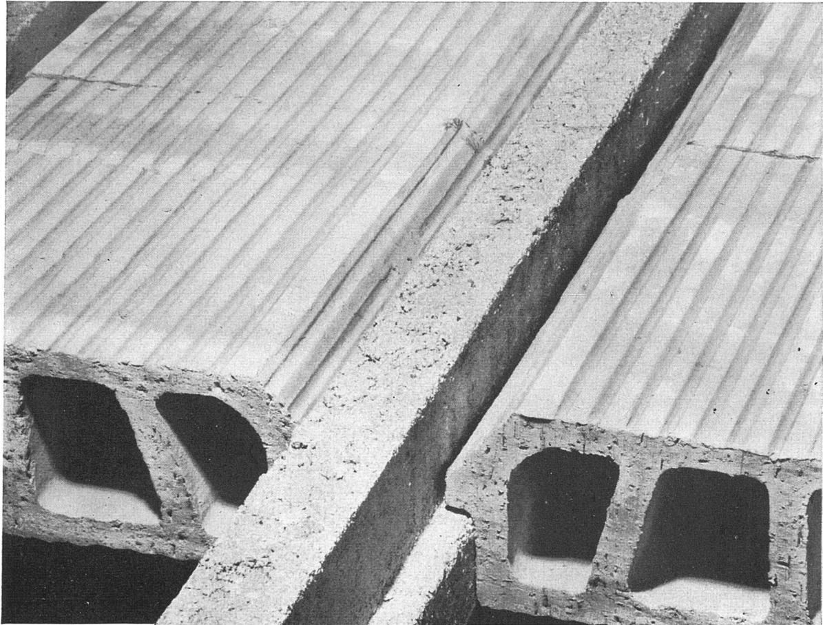
Seit 20 Jahren bewährt. Allein in der Schweiz weit über 1 Million Quadratmeter verlegt. Betonbalken mit handelsüblicher Isteigarmierung. Gut isolierende Deckensteine. Keine Schalung erforderlich. Einfaches, rasches Verlegen. Statisch einwandfrei. Verkürzte Bauzeit. Preislich vorteilhaft. Kleinere Deckenfelder für normale Wohnhausbelastung prompt ab Lager lieferbar. Kurze Lieferfristen auch für Sonderanfertigungen.
