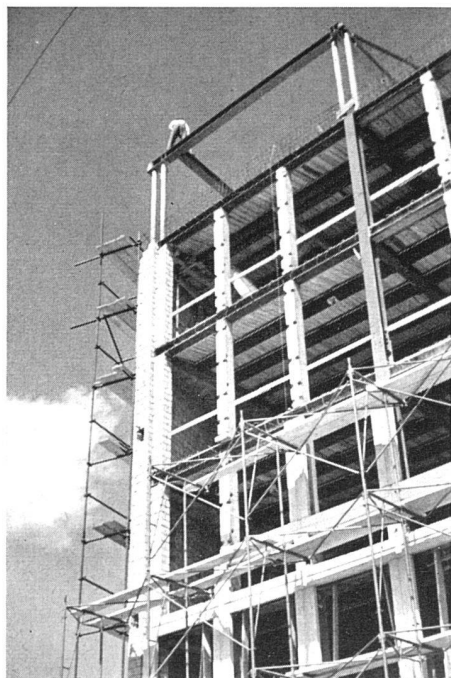
Einkleidung des Stahlskelettes | Revêtement du squelette d'acier | Covering of the steel frame Photo: HP. Nüesch, Architekt ETH
