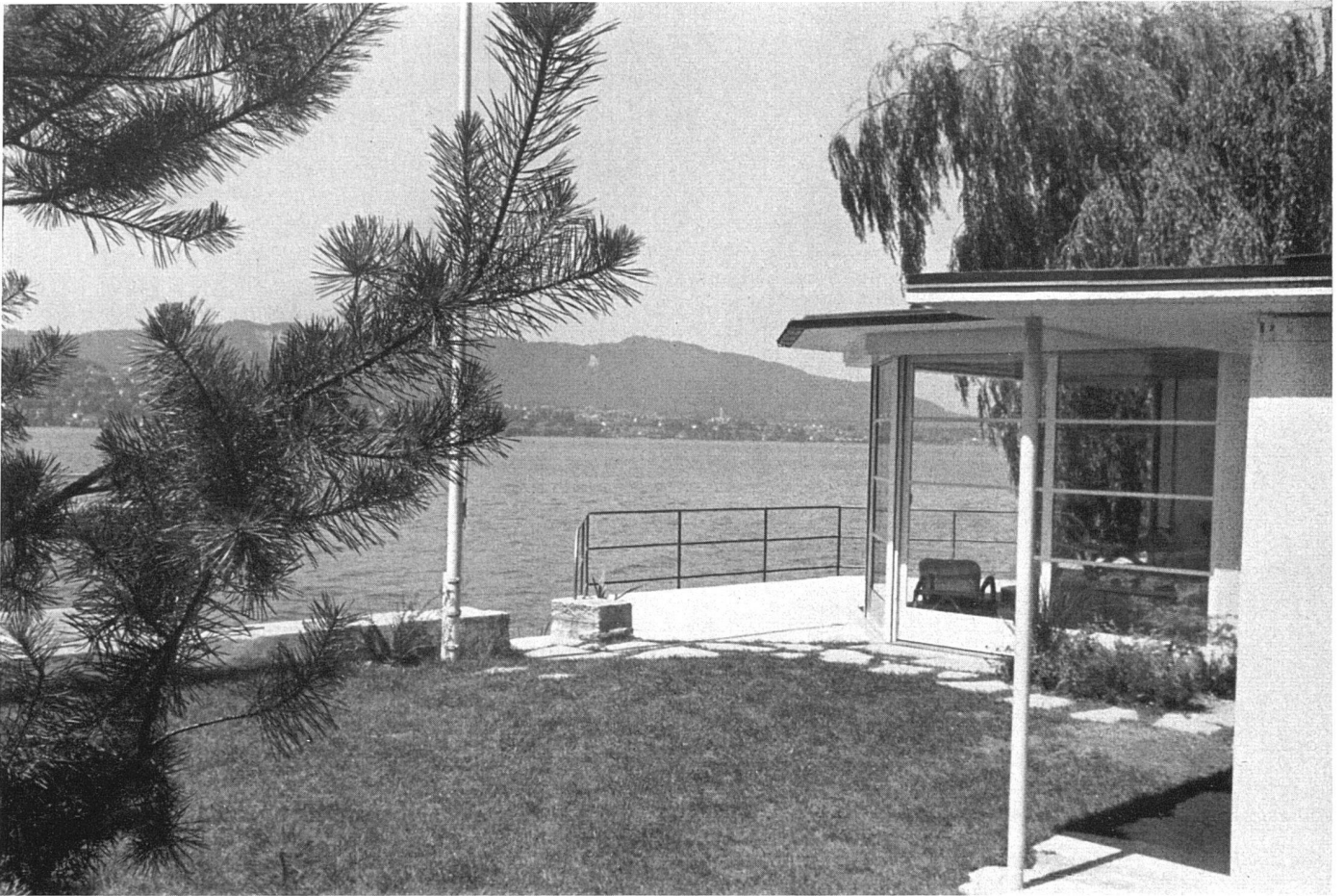
Wochenendhaus in Goldbach, B. & E. Gerwer, Architekten, Zürich | Maison de week-end à Goldbach | Week-end house in Goldbach
