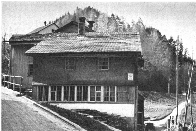
Abb. 5 Die durchgehende Fensterreihe im Erdgeschoß...
