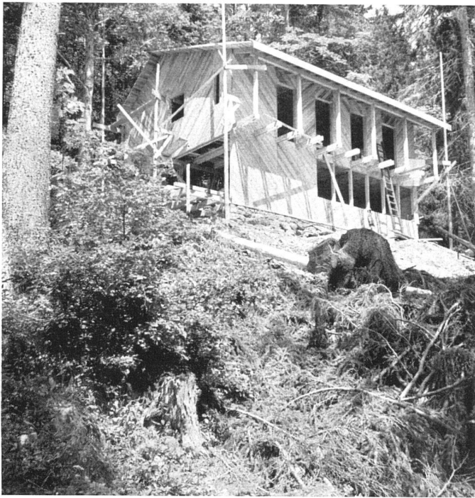
Ständer- und Zangenkonstruktion, diagonal verschalt | La maison en voie de construction | The house under construction
