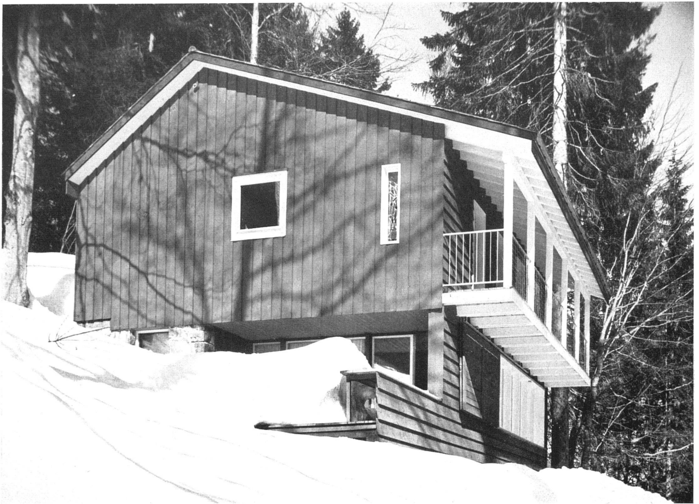
Ansicht von Südwest; Wände ungehobelte Schalung, schwedischrot | Vue prise du sud-ouest | View from south-west
