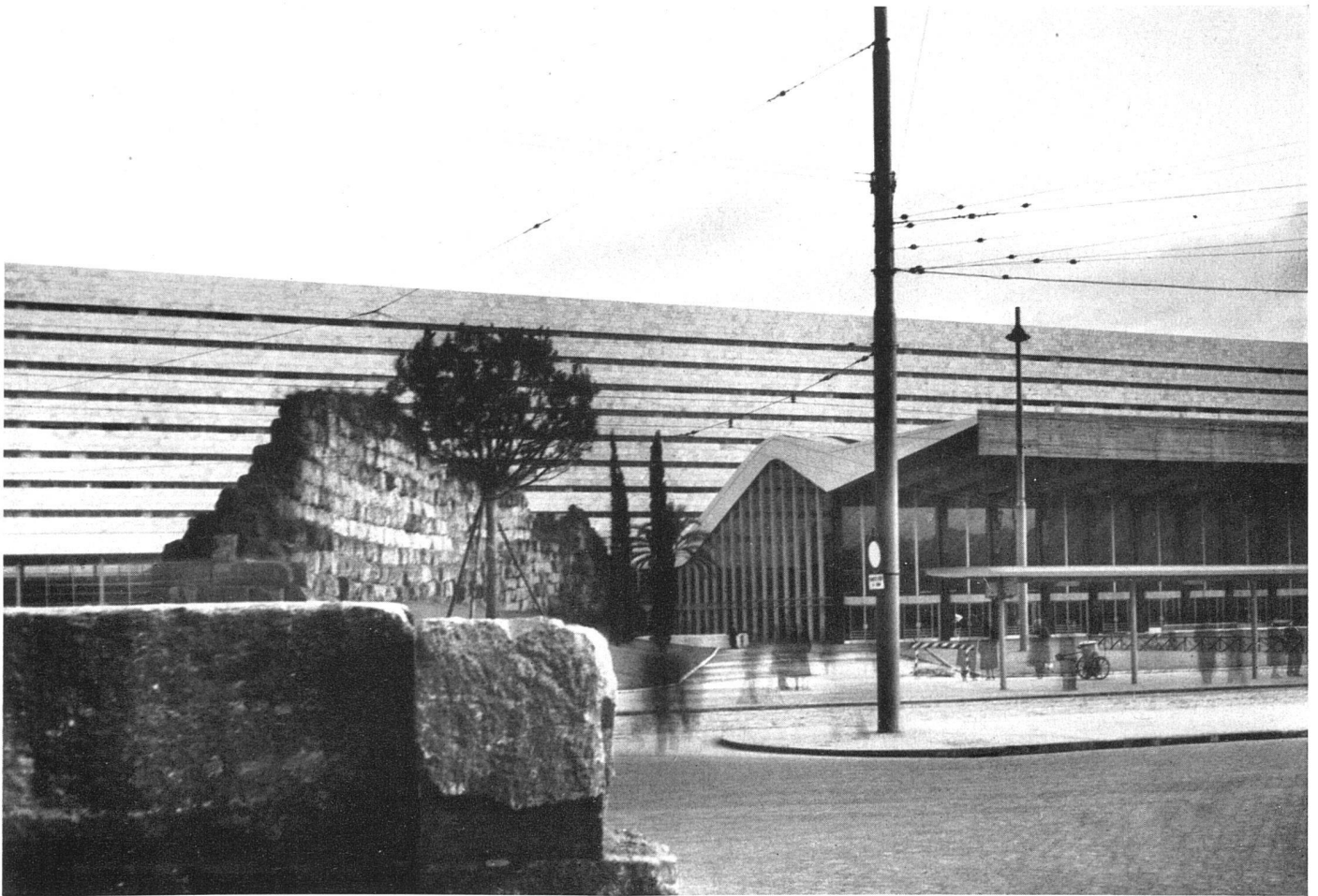
Schalterhalle und Bürotrakt mit Resten der antiken Stadtmauer, deren Silhouette vom Dach der Halle nachgezeichnet ist | Vue extérieure de la salle des pas perdus et du restaurant; au premier plan, les vestiges de l'ancien mur d'enceinte | Main hall and office wing with ruins of ancient city walls
