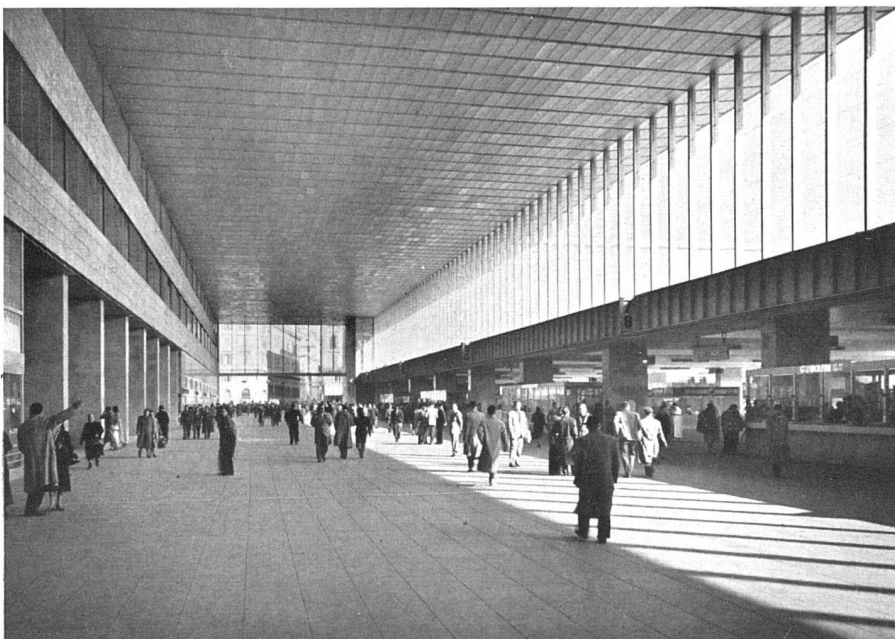
Kopfgalerie mit Blick gegen die Via Marsala. Rechts die Bahnsteige, links Durchgang zur Schalterhalle. Die Decke ist mit Alumanplatten verkleidet, die in verschiedenen Grau spielen | La galerie intérieure vue dans la direction de la Via Marsala | Head gallery with view to Via Marsala. Right, platforms; left, passage to the ticket-office hall
