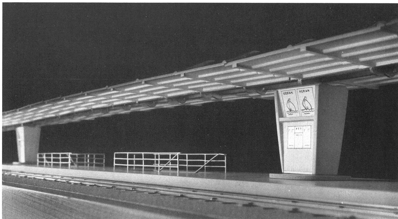
Ein Bahnsteigdach, das seine Nebenfunktionen (Apparateschränke, Telephonkabinen, Automaten, Plakate) technisch und formal ins Ganze einbezieht. Modellaufnahme | La toiture de quai intègre à l'ensemble ses nouvelles fonctions techniques et formelles (armoires pour appareils, cabines téléphoniques, distributeurs automatiques, affiches). Maquette | Model of a platform roof where the subsidiary functions (apparatus lockers, telephon cabins, automatics and posters) are harmonized both technically and formally with the whole
